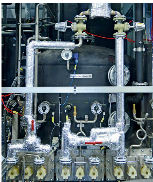
Heute versorgt rund 130 °C heißer Wasserdampf die Heizregister der Reinigungsanlage, die vor der Installation der Wärmerückgewinnung elektrisch beheizt werden mussten.
